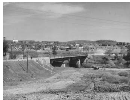
Construction du pont Albiny-Paquette au même moment que l'asphaltage de la route.
