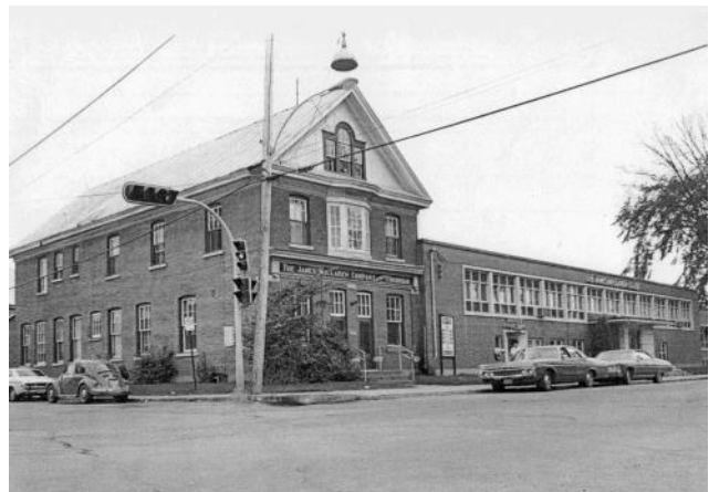
Les bureaux de la James MacLaren Co., rue de la Madone, suite à l'agrandissement de leurs locaux (vers 1950). Source : Collection Dr Otto Siebert de la SHGHL.
