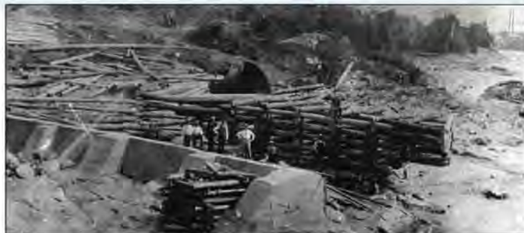
Construction de la 1 ère digue en 1911. On voit une des deux parties en ciment et le caisson de bois qui les relie.
