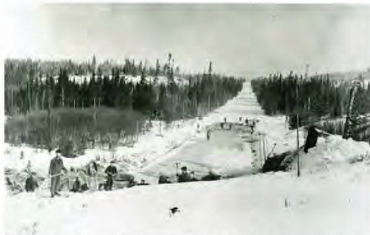
Construction de la route 117 vers l'Abitibi (1938-1939). Les ouvriers travaillent au pic et à la pelle pour 1$ par jour.
