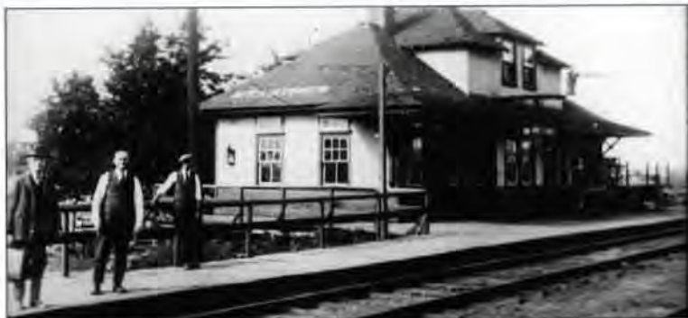
La gare telle que construite à l'origine.
