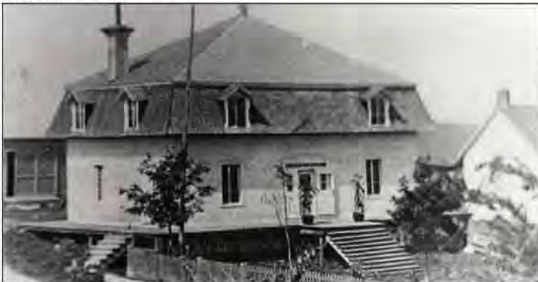
Le presbytère-chapelle construit en un mois en 1896
