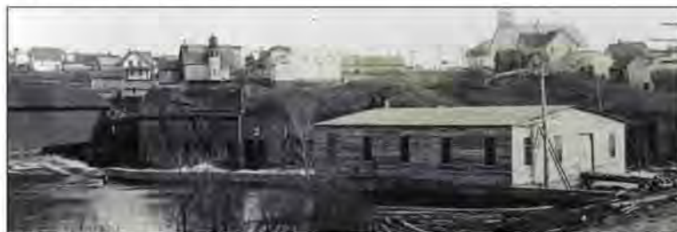
À droite le bâtiment de la centrale, à gauche le moulin Limoges-Brière abandonné.
