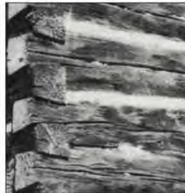
Assemblage à queue d'aronde ou à tête de chien.
