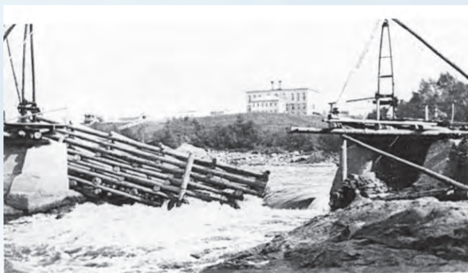
Construction du barrage en 1912
