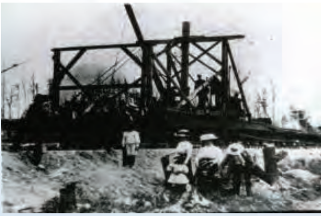
Chemin de fer en construction, 1909.
