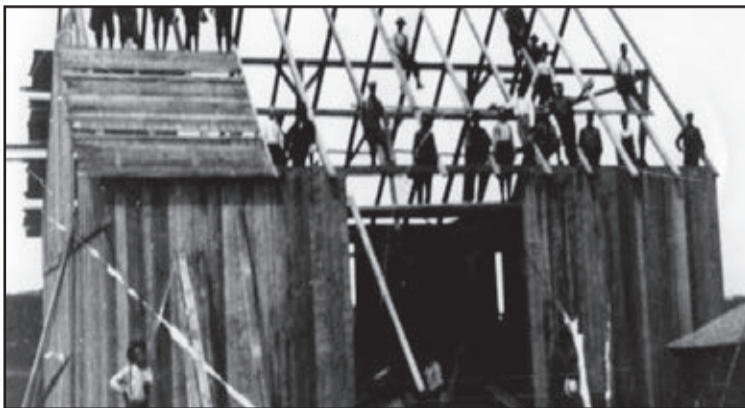
Corvée à Ferme-Neuve pour la construction d'une grange.
